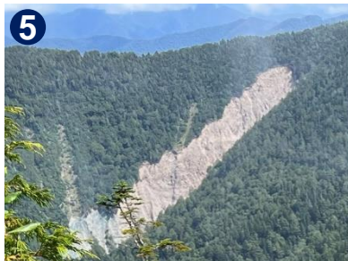
5 帝釈山から見た田代山です。崩落現場の傷跡が生々しいです。この上に木賊に続く登山道があります。
