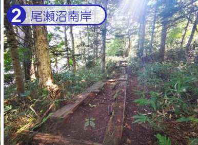
2 尾瀬沼南岸 尾瀬沼南岸の登山道には所々朽ちている木道もあり、また、古い木道は滑りやすいので気を付けましょう。
