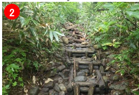
2 登山道上の階段の一部が破損しているため注意してください。
