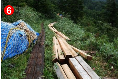
6 木道工事が始まっています。足元にはご注意ください
